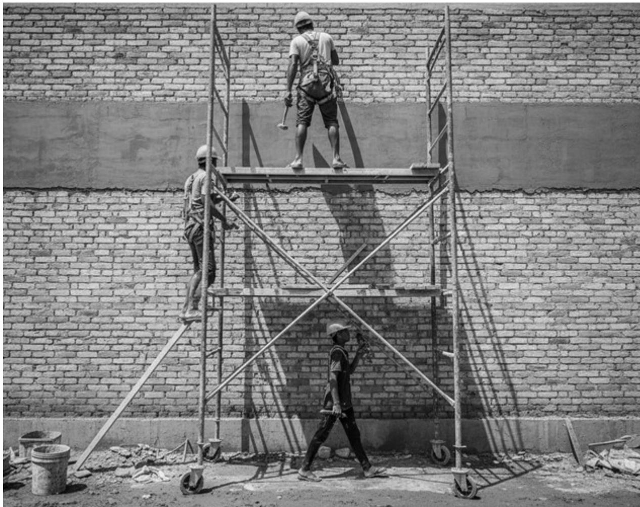
Cette image montre un échafaudage extrêmement dangereux. La base semble instable, soutenue par une planche de bois de fortune, et les roues ne sont pas bloquées. Les ouvriers grimpent sur la structure au lieu d'utiliser une échelle, et bien qu'ils portent des harnais, aucun point d'ancrage ni système antichute n'est visible. Un ouvrier marche sous l'échafaudage, ce qui représente un risque majeur d'être heurté si des outils ou des matériaux tombent.
