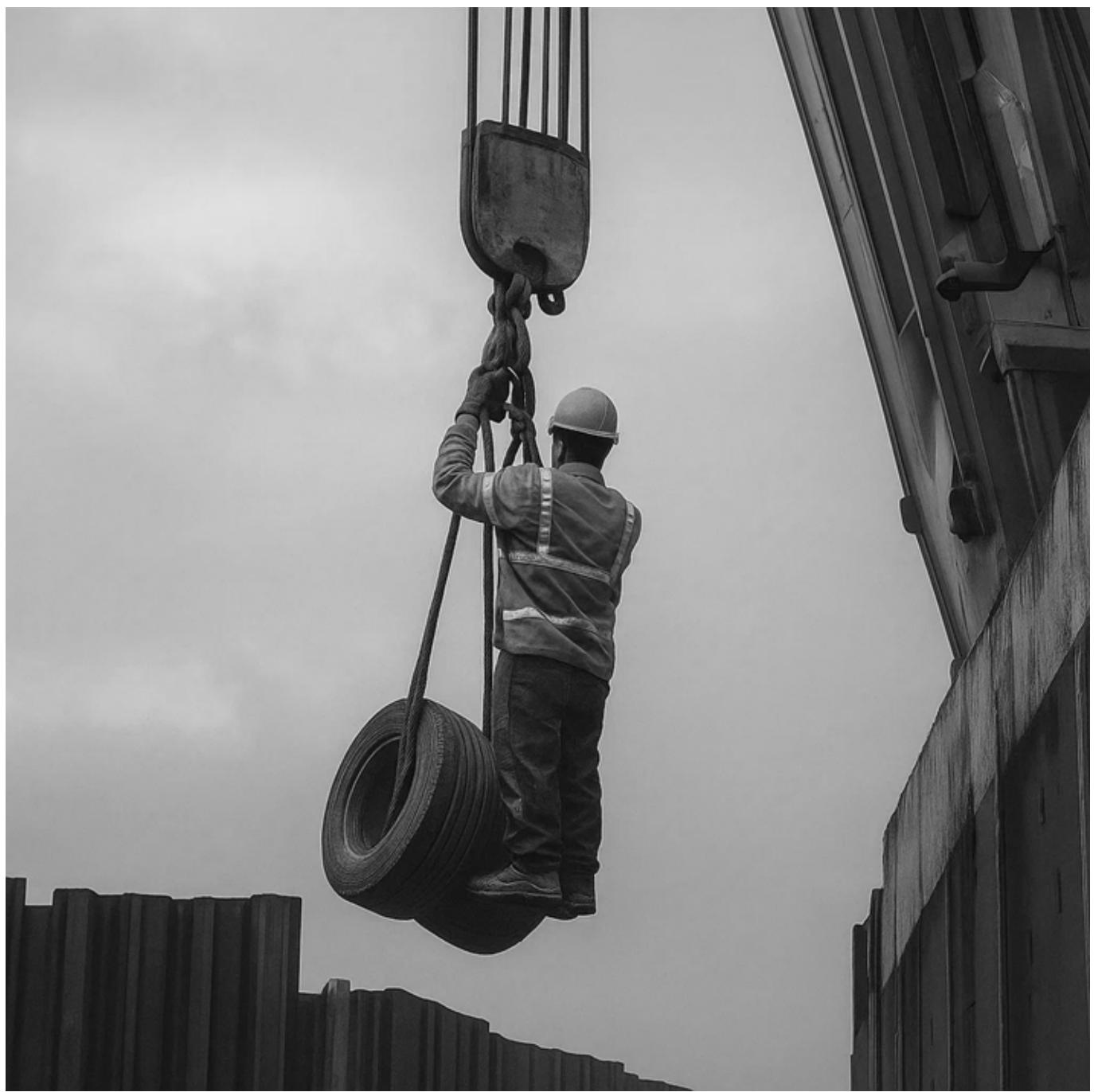
El trabajador está de pie sobre una carga suspendida (un neumático que se está elevando con un polipasto), lo cual es extremadamente peligroso. Este comportamiento infringe los protocolos de seguridad estándar para la elevación de cargas. Si la carga se desplaza, se balancea o falla, podría provocar lesiones graves o la muerte. Además, esta acción pone al trabajador en riesgo de sufrir una caída desde altura sin que haya ninguna protección contra caídas visible.
